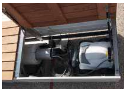
Zona práctica de almacenamiento
