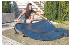
Aislamiento térmico del suelo
