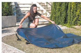
Aislamiento térmico del suelo
