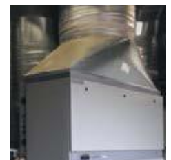
Ejemplo de instalación de conductos
